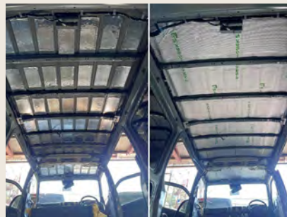
制振・断熱施工 施工箇所（フロントシート下・エンジンフード・スライドドア・リアサイド・バックドア・天井） ¥253,000
