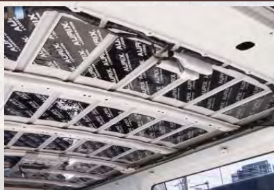
FD制振・断熱施工・・・¥253,000
