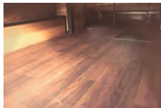
リア全面床張り ポンリウム仕上げ
